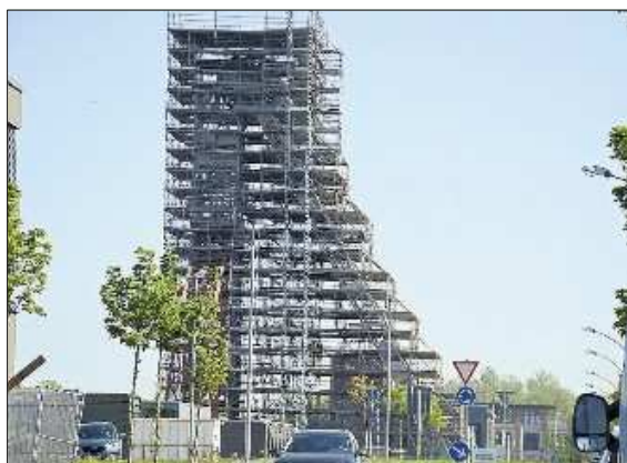
Der Zechenturm ist nicht mehr verhüllt, aber immer noch eingerüstet.
