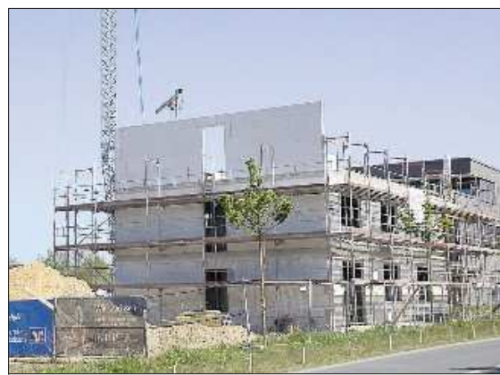
Auch das künftige Büro des Steuerberatungsbüros BPP macht Fortschritte.
